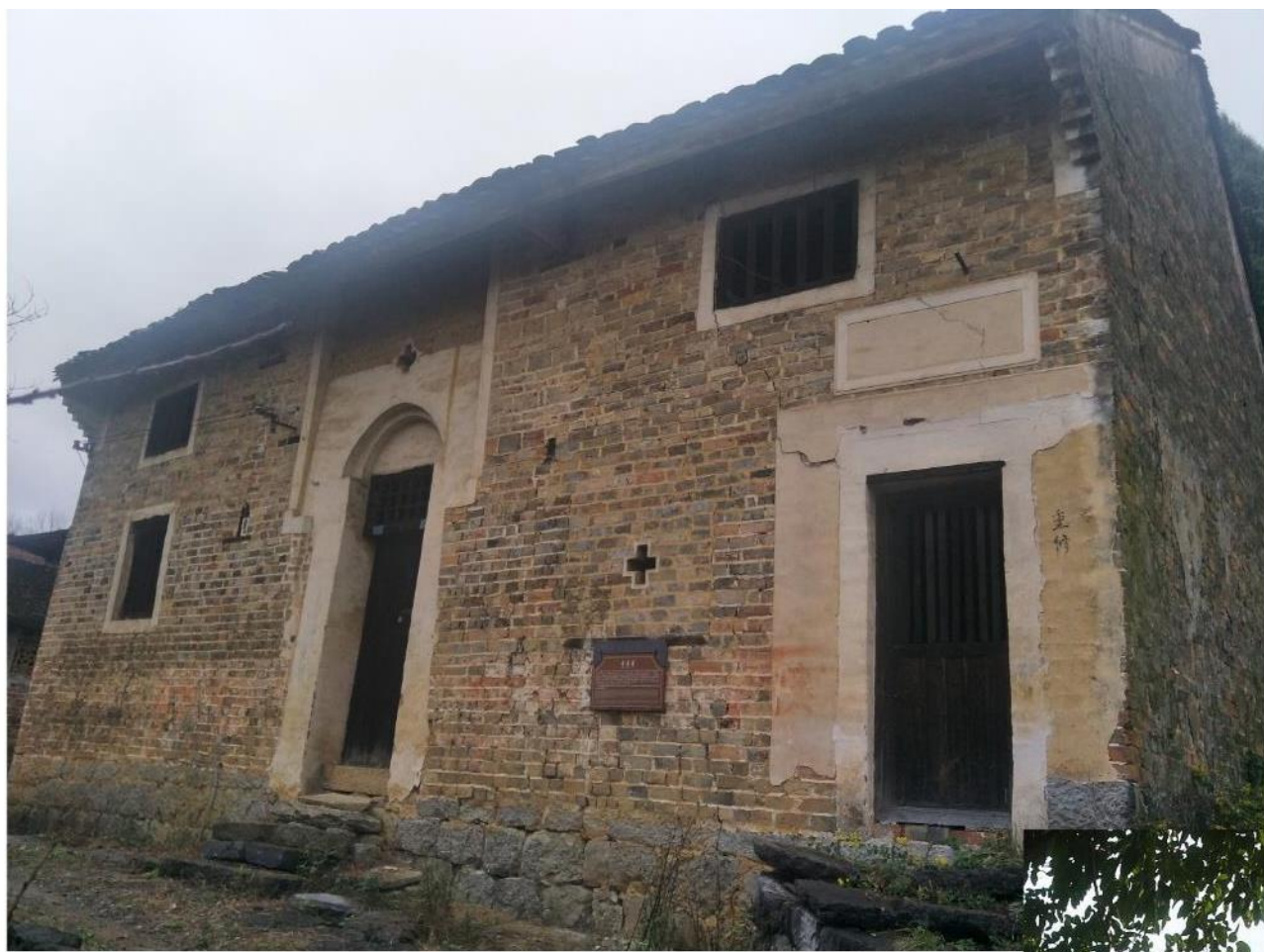
▲ 普善堂建筑现状
