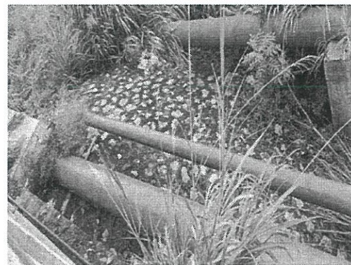
图 1.2-6 存在建筑垃圾
