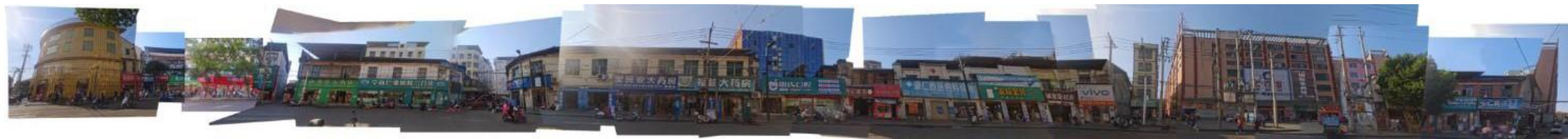
北正街西侧改造前 1-1
