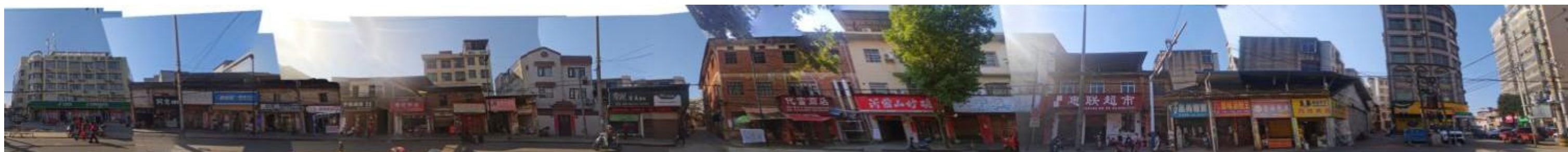
北正街西侧改造前 2-1
