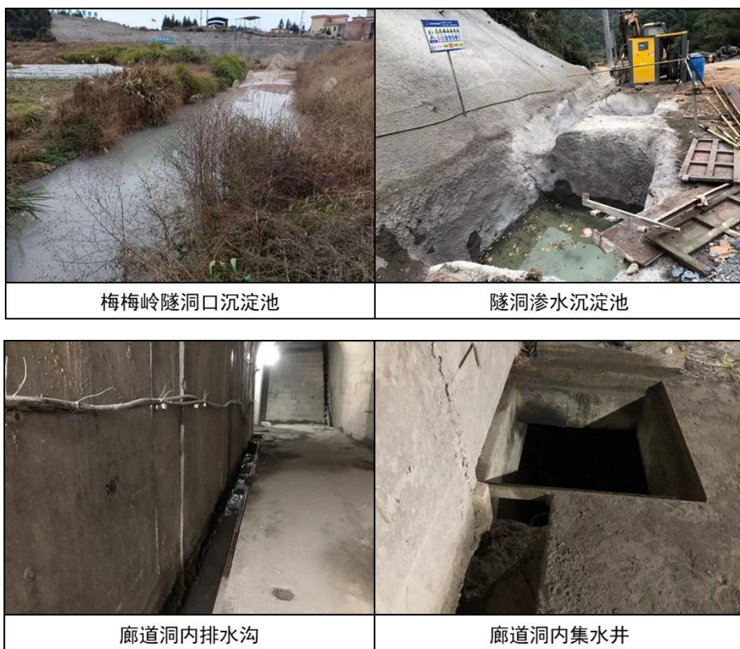
图 5.1-2 洞室排水处理措施现场照片
