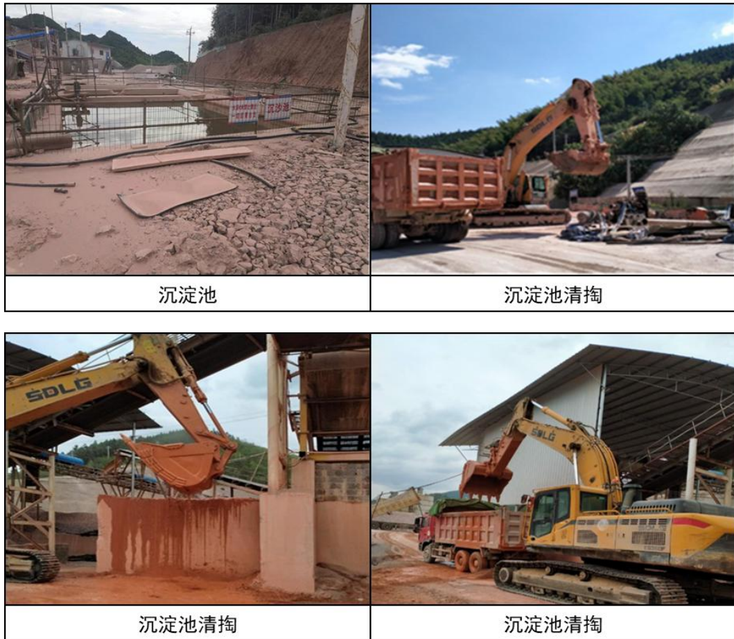
图 5.1-3 混凝土系统废水处理措施现场照片
