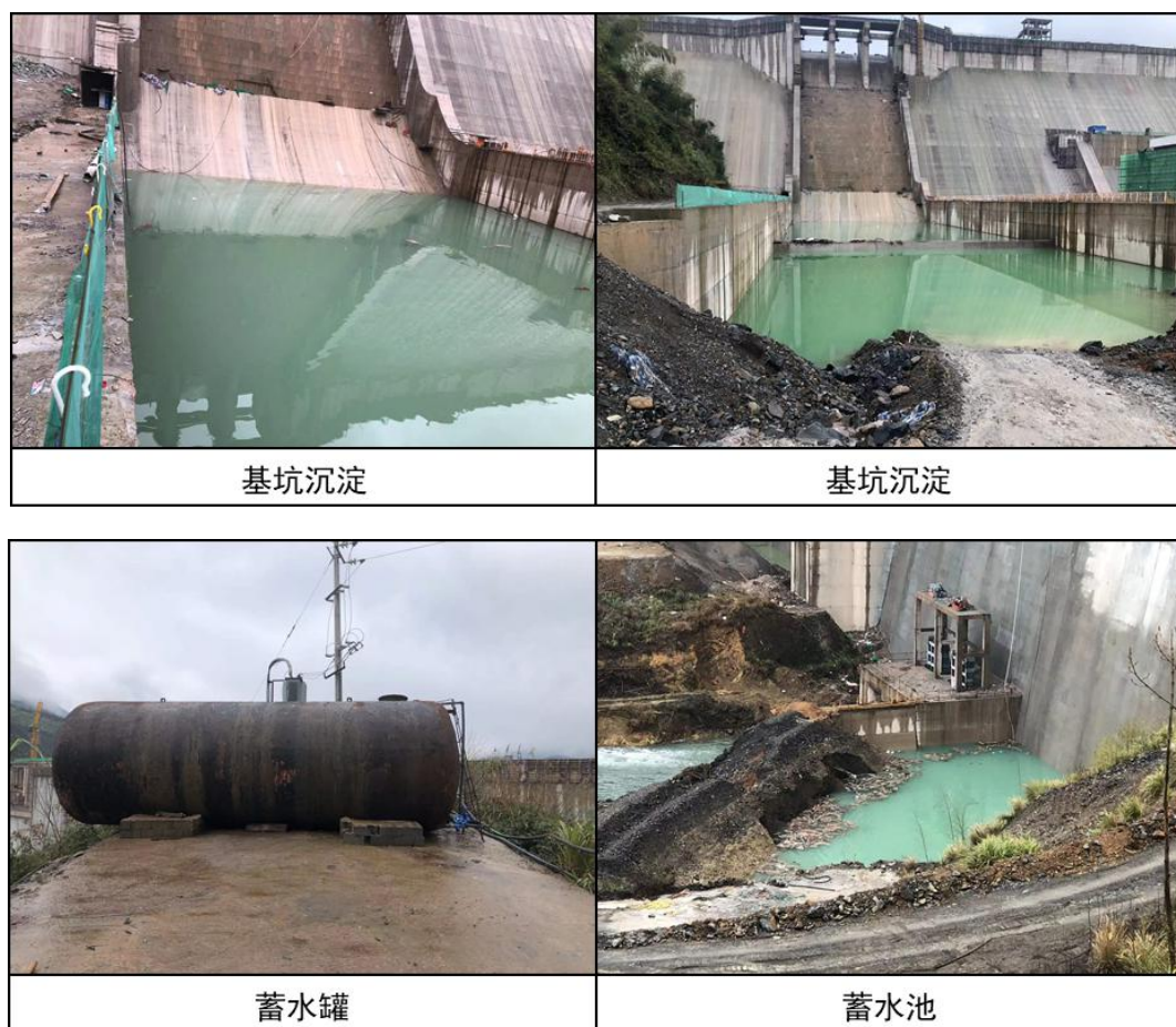
图 5.1-1 基坑排水处理措施现场照片
