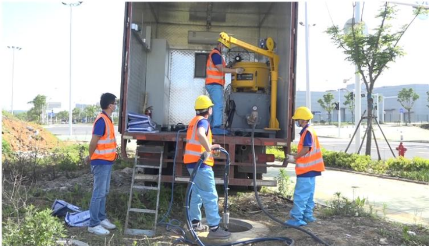
图 6.2.6-2 检查井喷涂现场作业图
