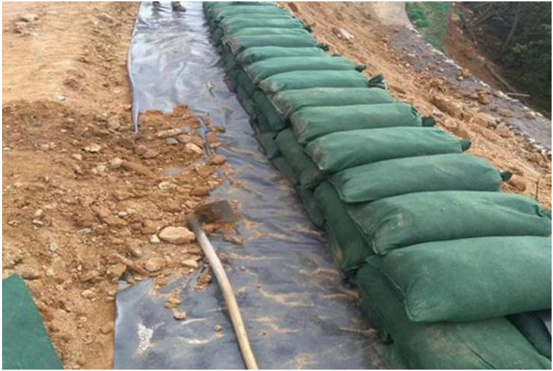
插图 4-3-3 台阶外缘生态袋堆砌示意图
