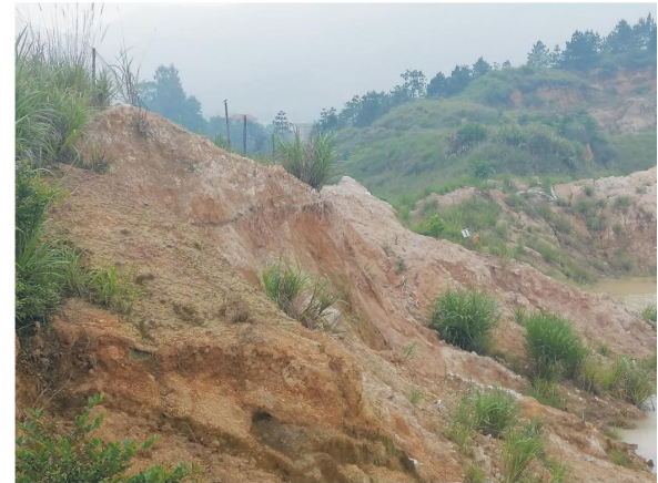
照片4 现状采坑最高边坡地段
