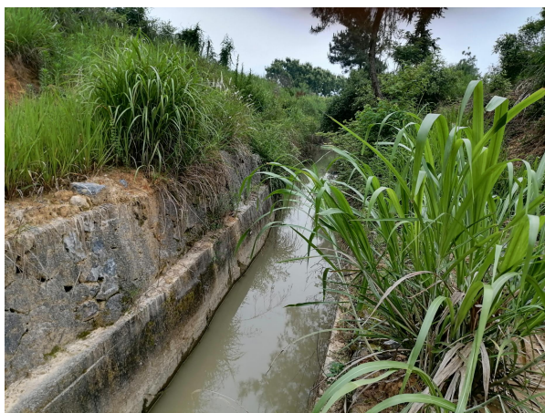
照片 2 加固水渠效果
