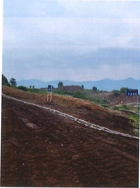
照片7 新建标识标牌
