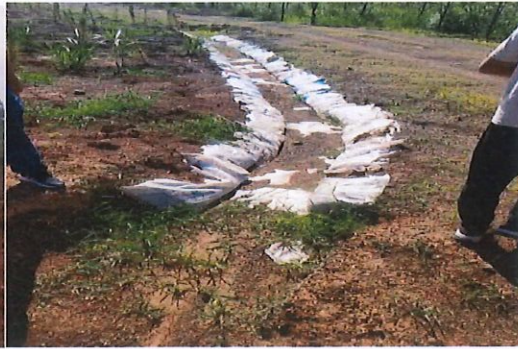
照片 6 复绿区排水沟（土沟）
