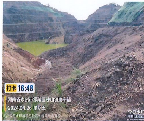
照片 10 L8 露采场现状
