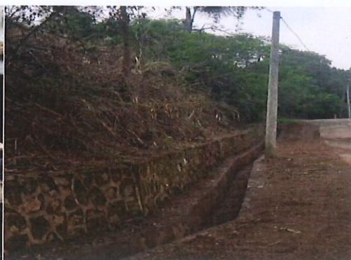
照片 12 矿山公路排水沟清淤
