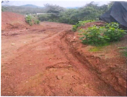
照片 9 排水沟（土沟）
