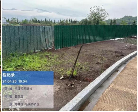
照片13 工业广场排水沟
