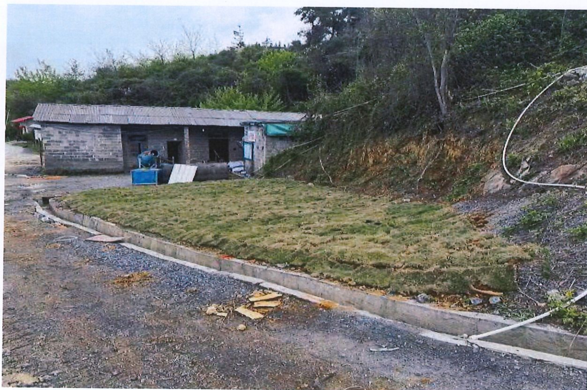
照片6 排水沟现状
