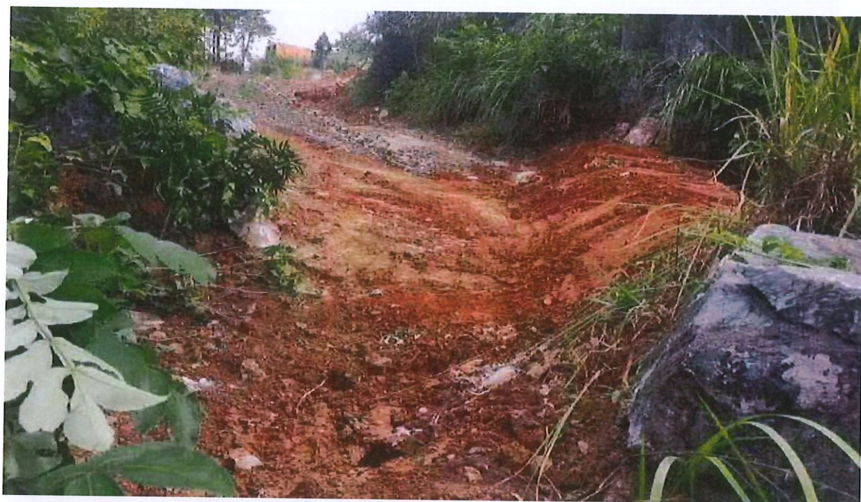
照片 13 矿山道路修建截排水沟整改后
