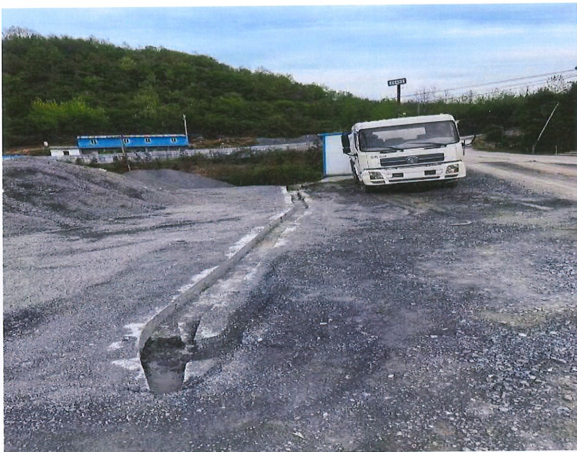
照片 11 矿区截排水沟现状
