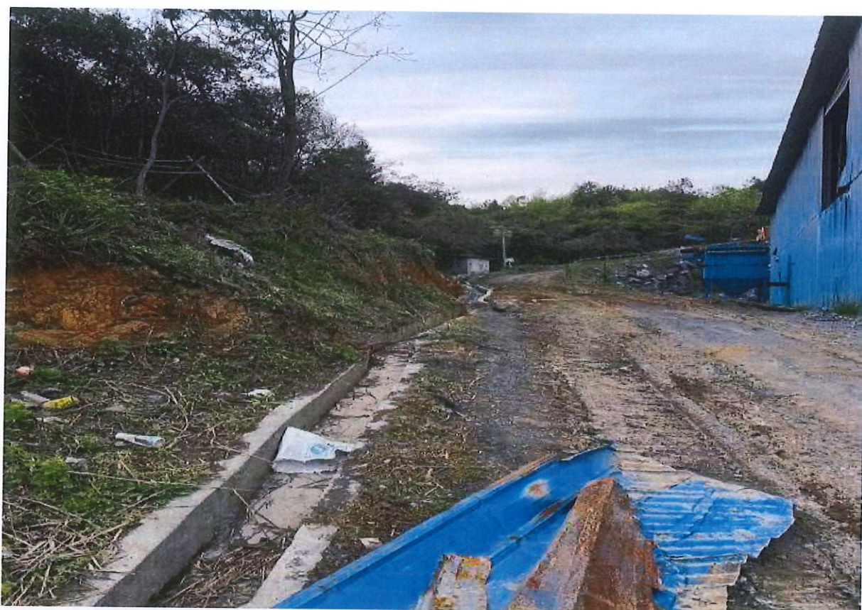
照片5 排水沟现状
